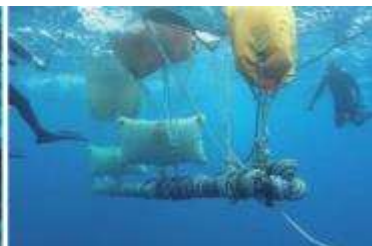
掘削編成回収状況
